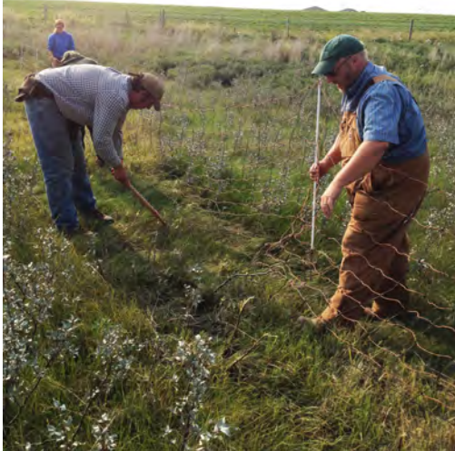
Installation de clôture en filet électrifié pour le pâturage
